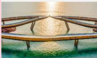
สะพานจูป
